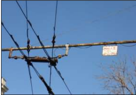
Figura 2-2: Suspensie rigidă, învechită
